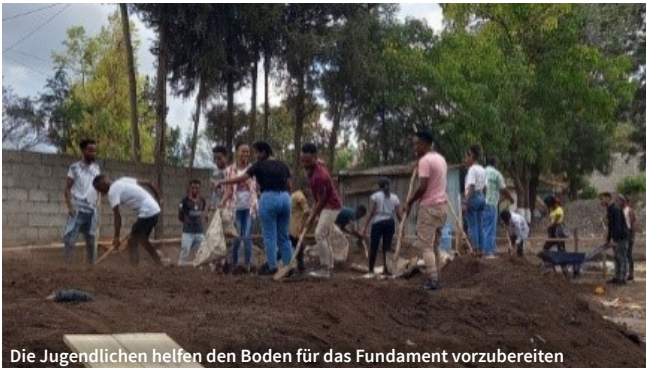
Die Jugendlichen helfen den Boden für das Fundament vorzubereiten
